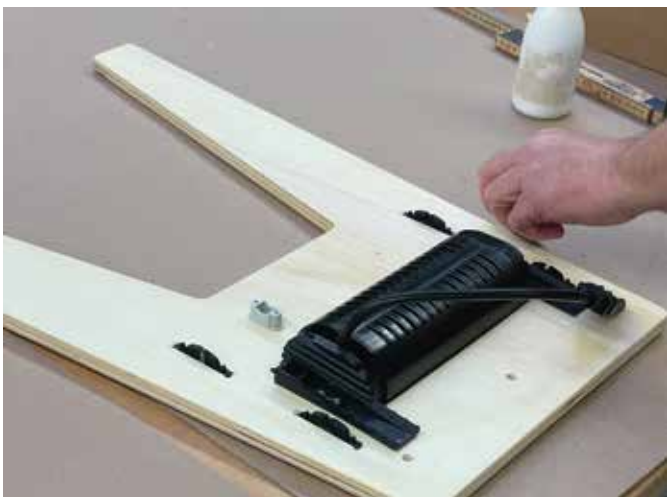
Die hochwertigen Steckdosen werden montiert.
